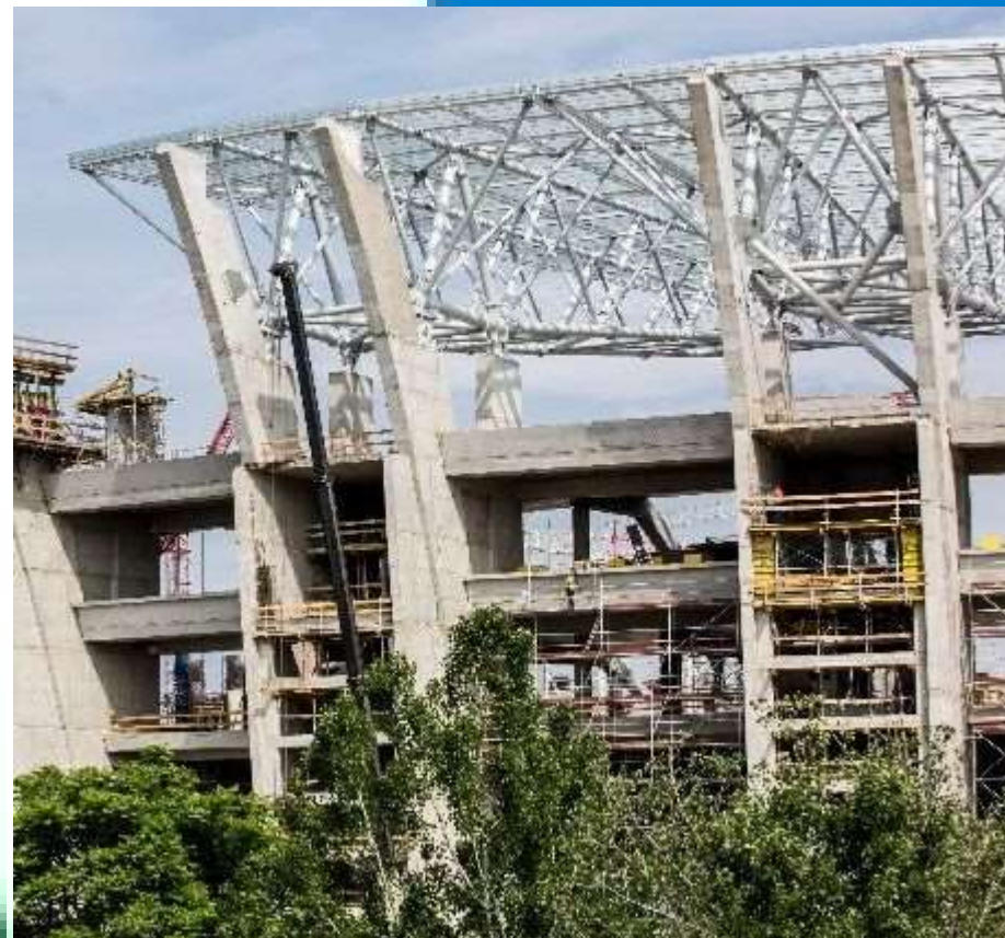
A 8. dilatáció 31-32 pilonja az elkészült, helyére emelt acélszerkezettel
